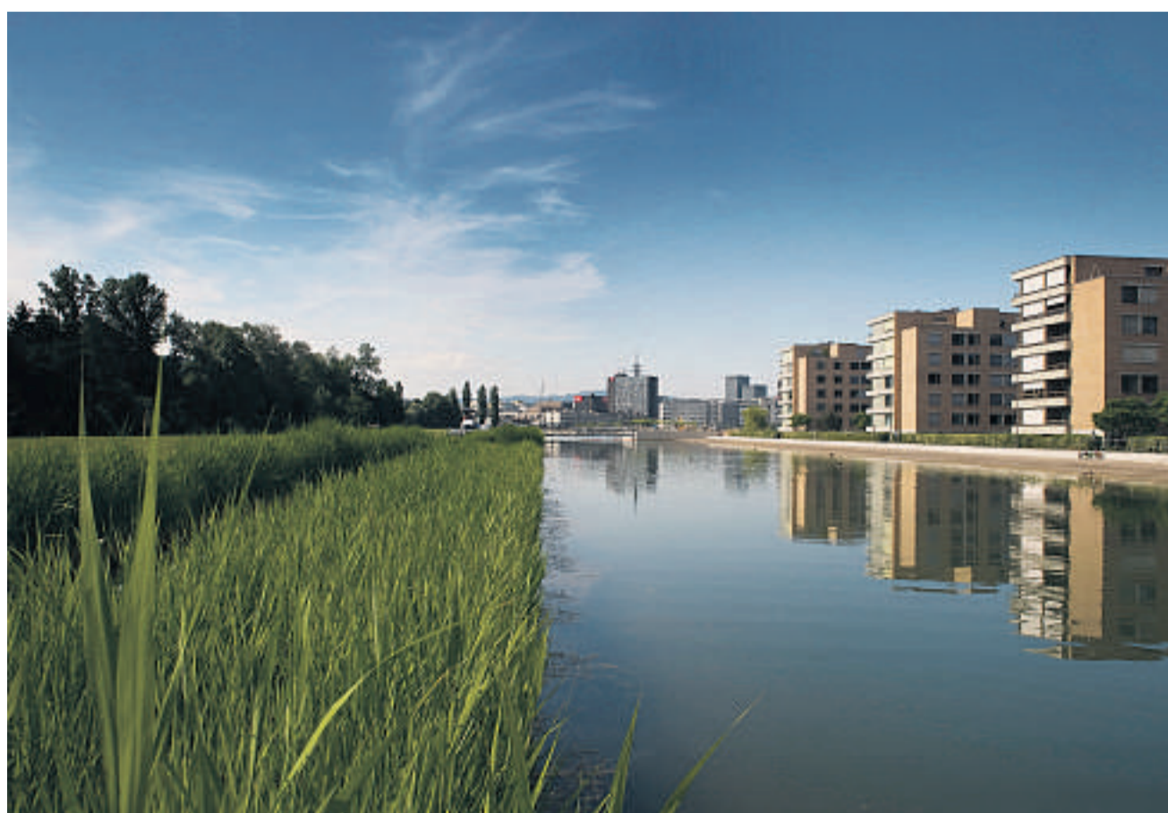
Die Melioration hat bis heute und auch im dichtbesiedelten Gebiet ihre Funktion – im Bild der Glattpark.
